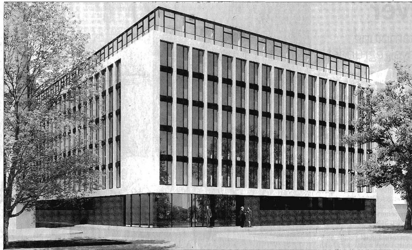
Raumhohe Fenster bilden die neue Fassade, und zwei zusätzliche Geschosse vergrößern die Bürofläche des Polis-Projekts am Rheinufer.
