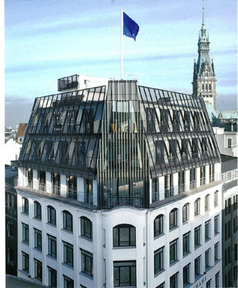
UG-4. OG Bestand: Stahlbeton-Treppenhaukern neu; 5.-7. OG (Staffelgeschosse) Neubau, Stahlbetonkonstruktion, WDV5; Penthouse Stahl-Glaskonstruktion; Putzfassade EG-7. OG; kompletter Fenstertausch; in den Etagen 6-7. OG vorgehängte Streckmetallkonstruktion; Gebäudeecke: gläserner Erkerbau durch senkrechte Blechlamellen gegliedert **Größe** BRI: 10 350 m<sup>3</sup>, NF ca. 2400 m<sup>2</sup> **Kosten** Gesamtbaukosten: 3,9 Mio. €, Quadratmeterpreis BGF: 1300 € **Standort** Große Bäckerstraße 13
